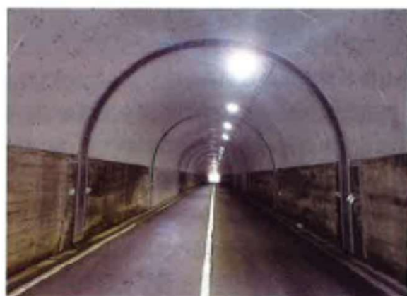
写真－3 室沢トンネル（工事完了後）
