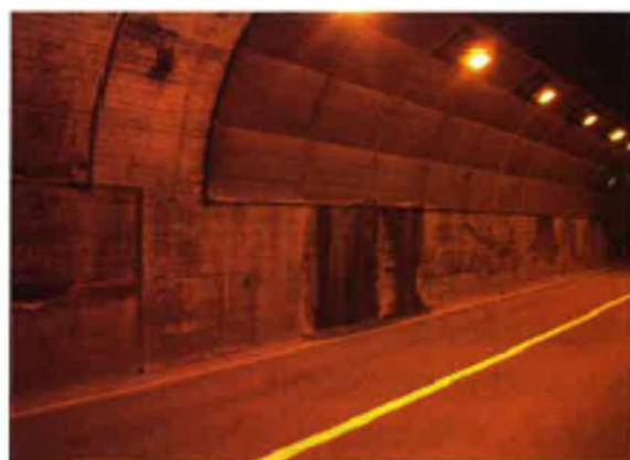
写真-2 室沢トンネル（工事実施前）
