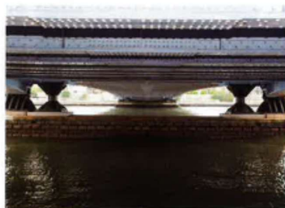
写真-1 永代橋の既設支承と新支承
